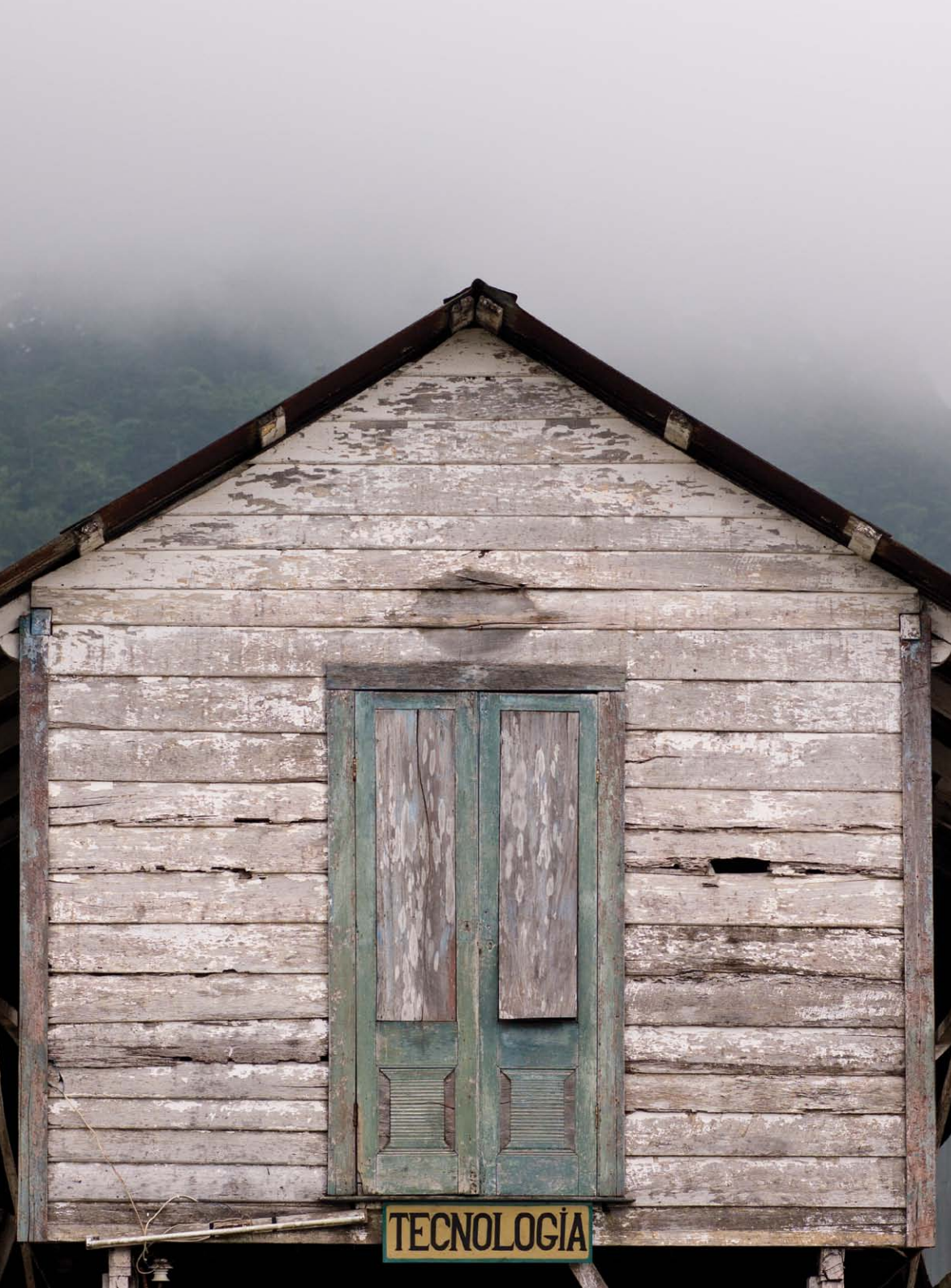
200 Budynki techniczne, m.in. suszarnie kawy przy plantacji Monte Café | Infraestrutura técnica, entre outros, para secagem de café | Technical buildings, for example coffee drying houses at the Monte Café plantation Monte Café
